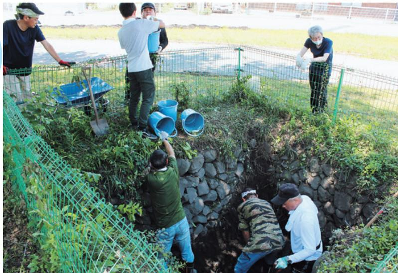
まずは梅雨の間隙を縫って、7月20日に、あちこちにある排水溝に溜まった土の除去作業を行いました。重いグレーチングを持ち上げるだけで汗が噴き出しましたが、ひたすら掘りまくって、排水溝はきれいになりました。
