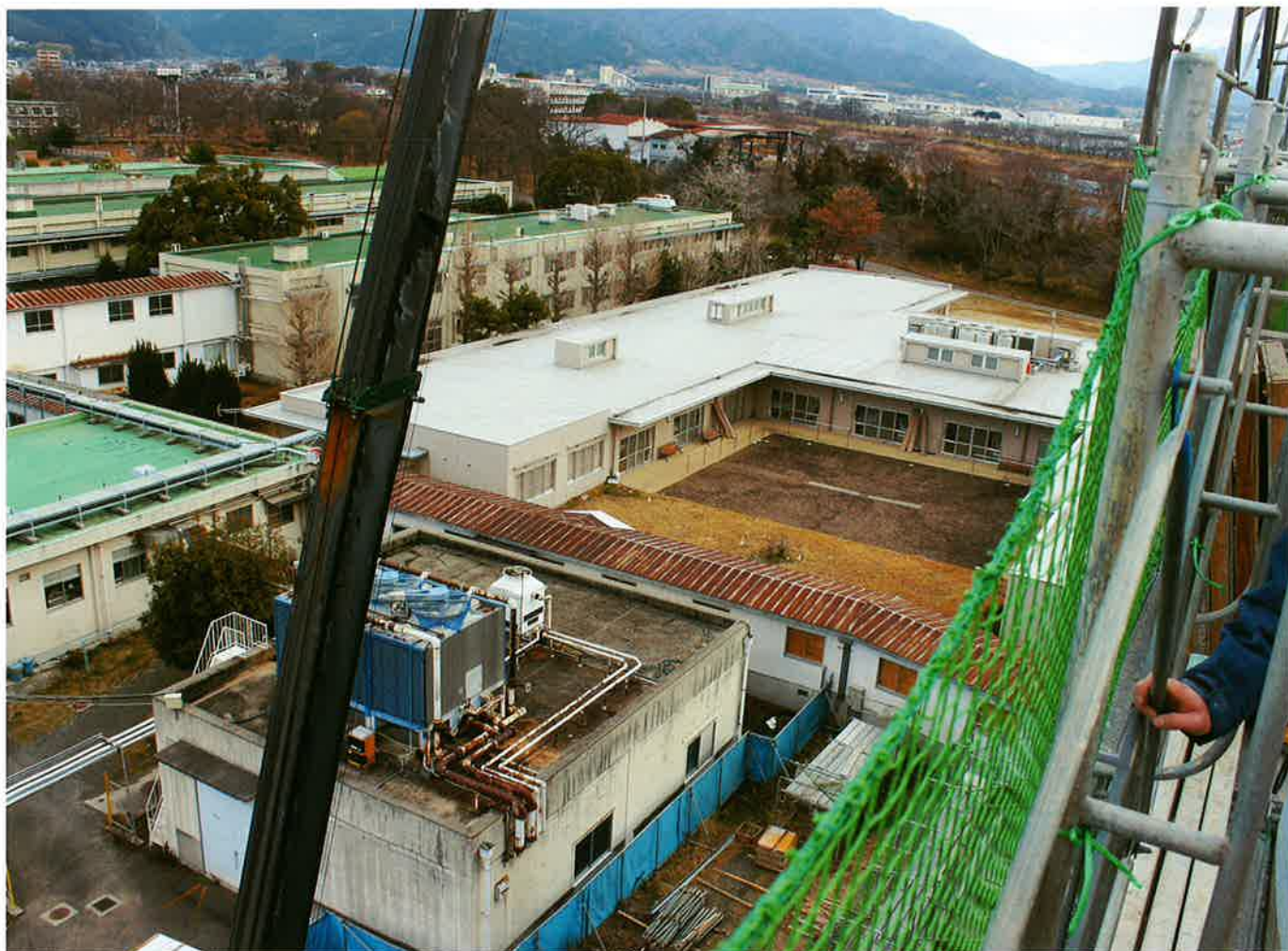
建築中の足場（5階床部分：地上約20メートル）から見た風景
